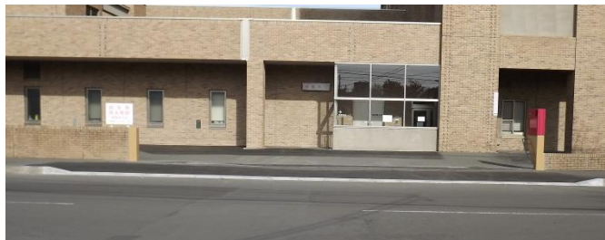
施行後 搬入口13.5m 車道と縁石の段差なし
