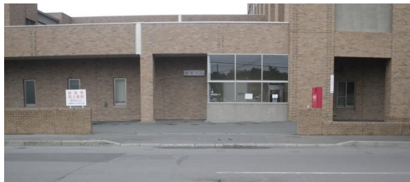
施行前 搬入口9.5m 車道と縁石の段差あり
